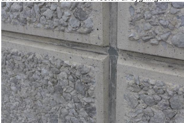
Eftersynshallen, detalje af betonelementer på nordfacaden.
