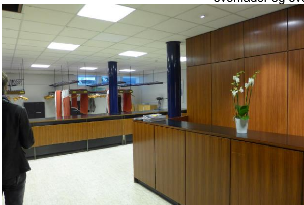
Garderoben i kælderen i forhuset med det originale fine faste inventar. Vandrette bordflader er sorte, lodrette finerbeklædte. Gulvet er belagt med travertin.
