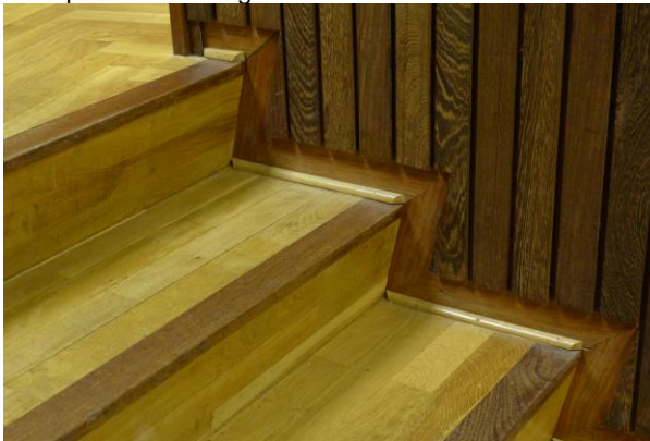
Mellemgang ved den vifteformede auktionshal. Parketgulvet er ført videre ned ad trappen. De omhyggeligt planforsænkede forkanter i hårdt træ danner fin kontrast til trinfladerne.
