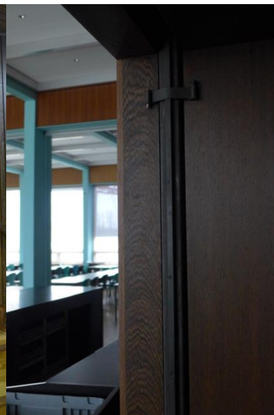
Den indbyggede ekstra skydedør mellem forhal og kantine (opr. auktionshal).
