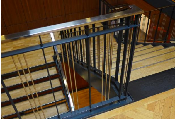
Trappe i forhuset, 1.sal. Vanger og de bærende dele af trappegelænderet er sortmalet støbejern, håndlisten og de tynde lodrette strenge er blankpoleret messing.
