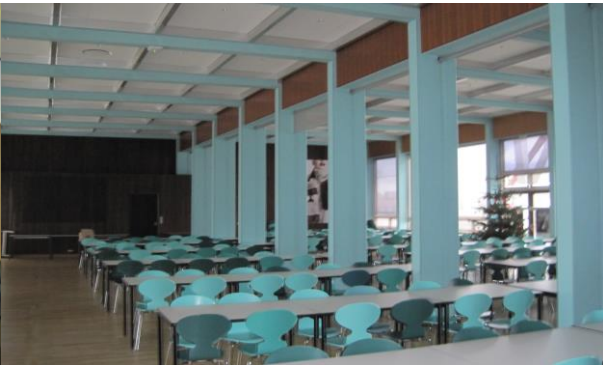
Kantinen med den synlige søjle-drager-konstruktion. Loftet er nyt, gulvet er delvist nyt. Den langsgående drager har stadigvæk en rest af den oprindelige finer.
