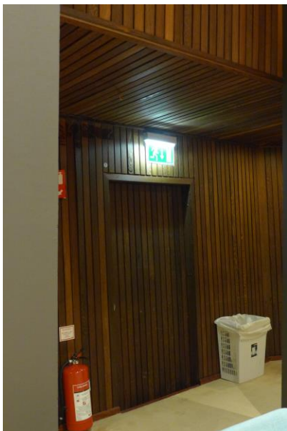
Listebeklædt væg i den vifteformede auktionshal.
